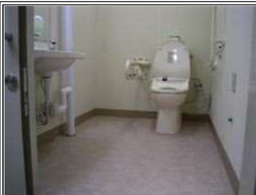
入り口を広めに取り、 入って正面に便器を設置しました
