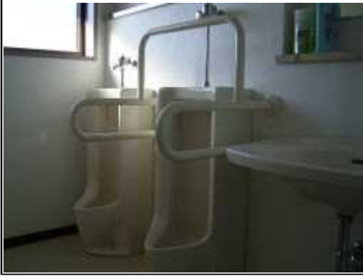
手前の便器に手摺をつけました
