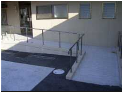
入り口にはスロープを設置しました
