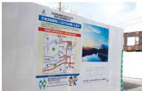
ジョイボリス跡地工事用仮囲い (協力:両備ホールディングス株式会社)
