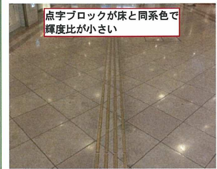
図. 視覚障害者誘導ブロック
