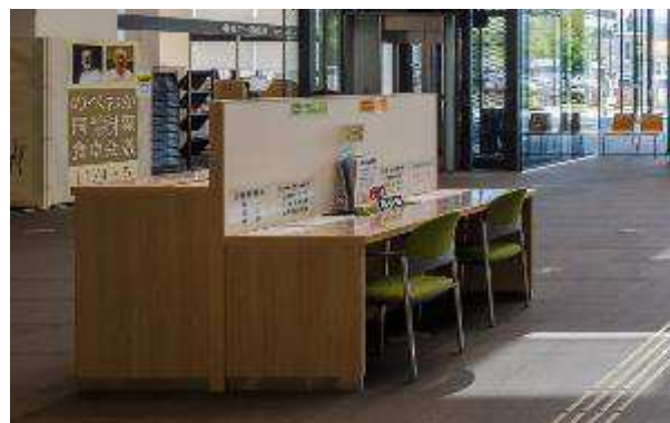
車椅子利用者にも使いやすい高さの記載台（延岡市庁舎）
