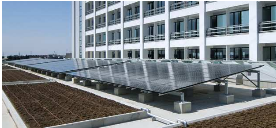
太陽光発電パネル（つくば市庁舎）
