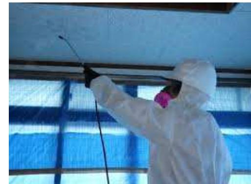
噴霧器(除去作業中の湿潤)
