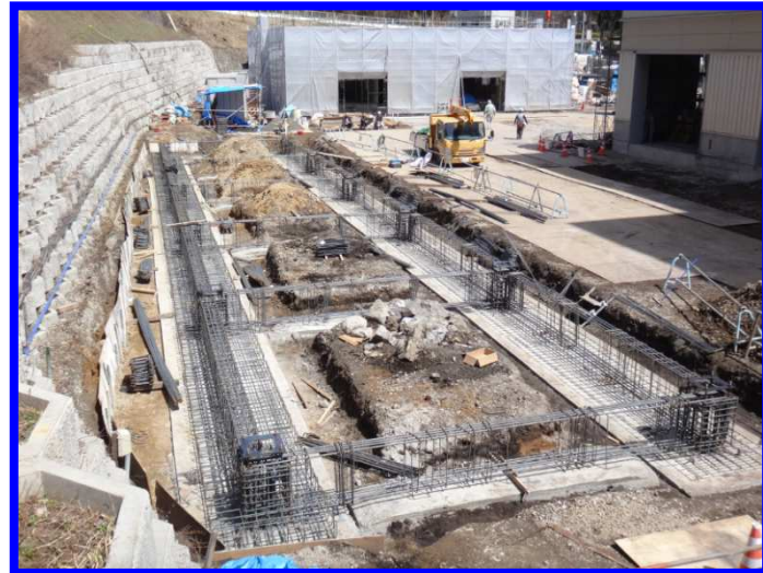
コンクリート工事
