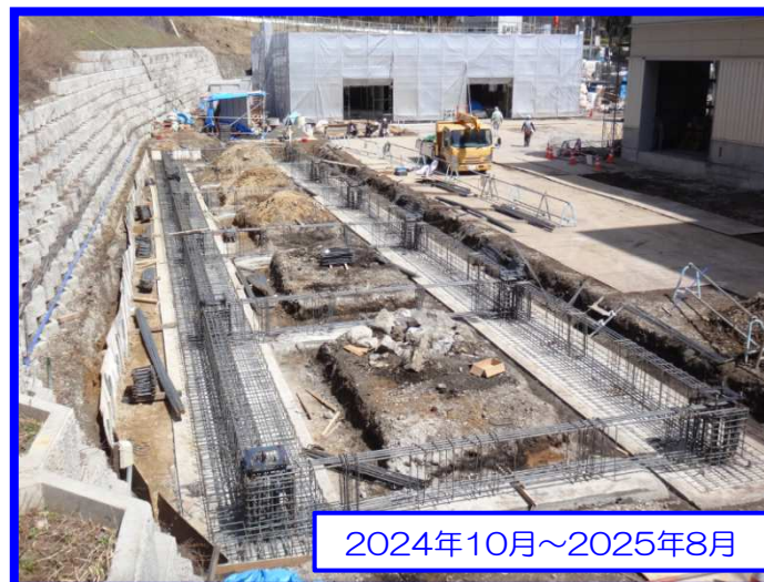
コンクリート工事
