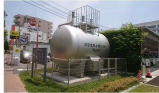
耐震性貯水槽 (20立方メートル) (岡山市水道局)
