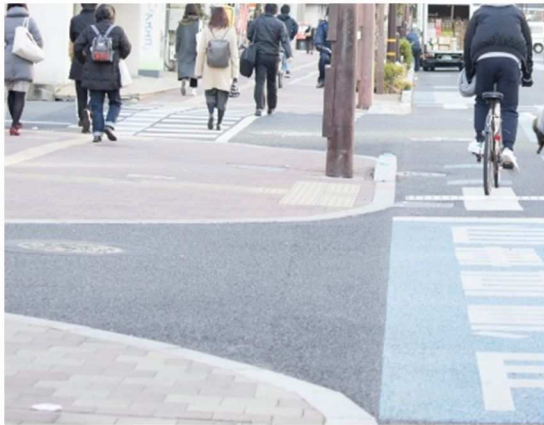
段差のない歩道
