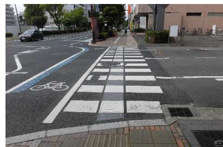
エスコートゾーンの設置 (市役所筋)
