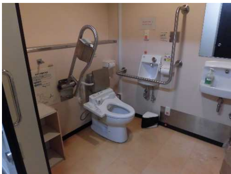
多目的トイレの設置 (岡山市役所本庁舎)
