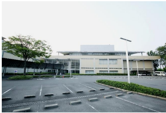
岡山県南部健康づくりセンター全景
