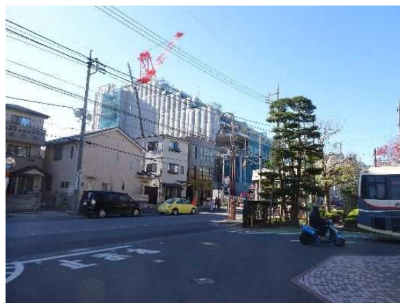
〔市民会館跡地の第1期工事〕
