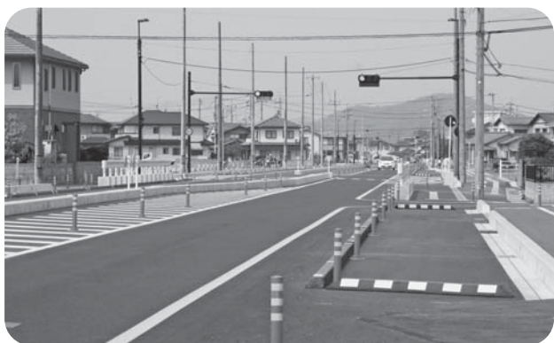
整備が進む都市計画道路竹田升田線
