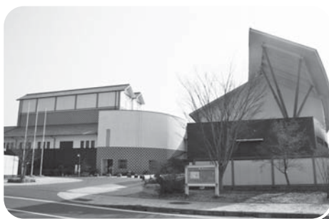
太陽光発電システムなどを設置予定の建部町文化センター
