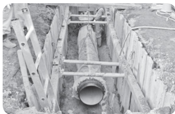
老朽管更新工事
