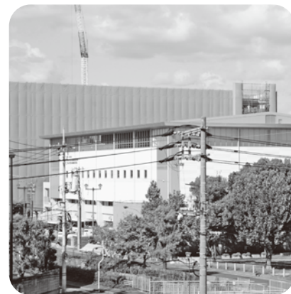
建設中の岡山後楽館中・高等学校 ～北区南方一丁目～
