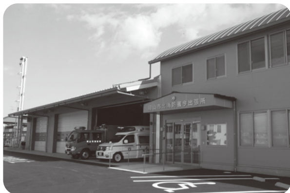
平成24年3月に開所した北消防署 今出張所
