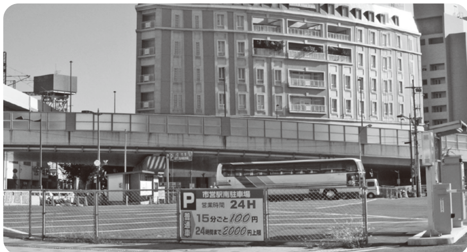
バス駐車枠を増設した市営駅南駐車場
