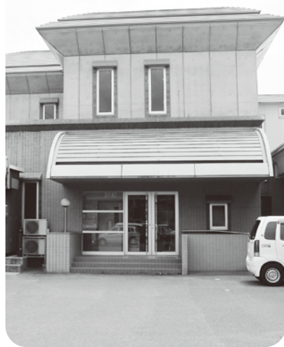
空き庁舎となっている 旧瀬戸町水道庁舎
