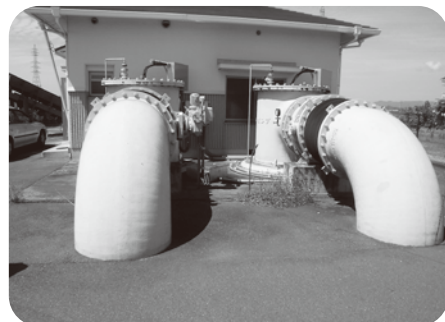
半役排水機場
