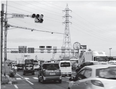
立体化される大樋橋西交差点
