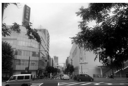
1車線化が検討されている県庁通り
