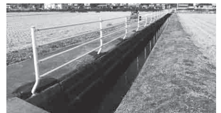
安全対策を実施した用水路
