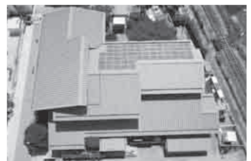
太陽光発電設備が設置されている一宮公民館
