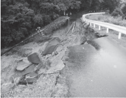
崩落した冠光寺池の堤体
