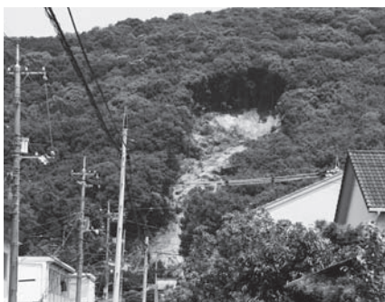
7月豪雨での土砂災害現場
