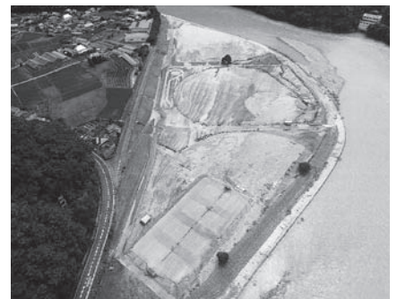
被害を受けた建部町総合スポーツセンター
