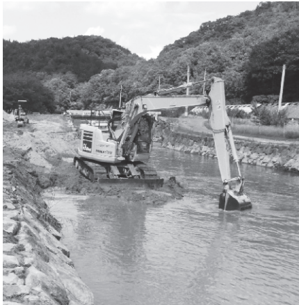
砂川での土砂撤去
