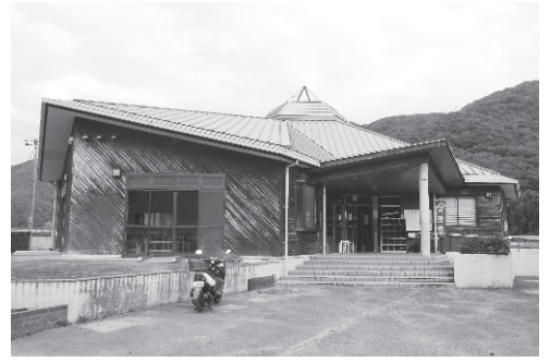
浸水被害にあった管理棟（平成30年11月撮影）
