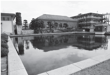
市内の約6割に給水している三野浄水場
