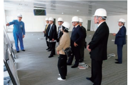
新庁舎建設現場（横浜市）
