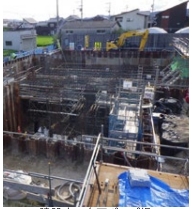
建設中の白石ポンプ場
