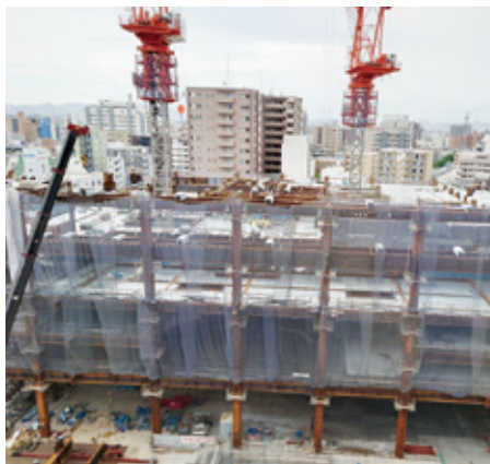
建設が進む新庁舎
