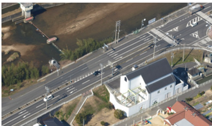
ポンプを増設した瀬戸雨水ポンプ場
