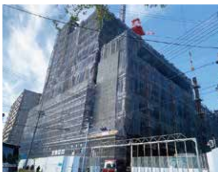
建設中の新庁舎
