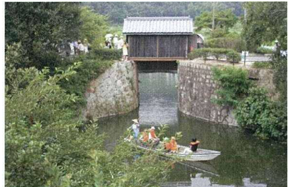
倉安川取水口としての「倉安川吉井水門」。
