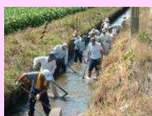
水路の泥上げ
