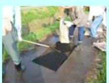
農道の部分補修
