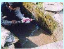
水路のひび割れ補修
