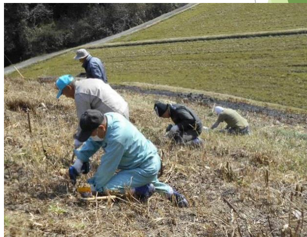
ため池法面の植物除去
