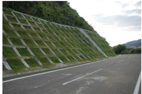
法枠内部への緑化がコンクリートによる無機質な印象を和らげている
