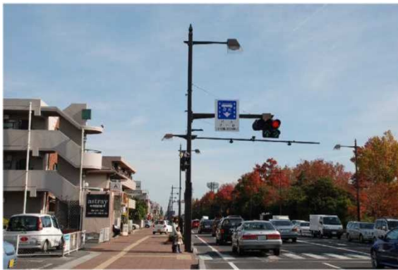
電線類の地中化や街路灯・信号機・標識類等の統合がすっきりした歩道空間を形成している
