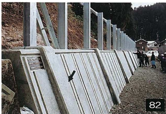
支壁とスリットを用いて、横に長い擁壁を分節化することにより、形を整えている（堀繁氏デザイン） （※堀繁著「景観からの道づくり」から転載）
