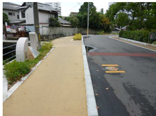
(残念な例) アスファルト舗装にペイントを塗った擬似土舗装は素材感が悪い
