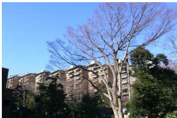
屋根の形状によるリズムカルなつながりに配慮した違和感のない街並み
