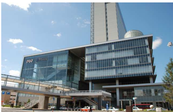
開放的なファサードのデザインが、まちの賑わいやつながりを創出している
