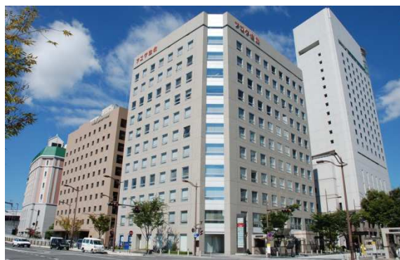
建築物の高さ、ファサードのデザイン、色彩などについて街並みの連続性、つながりに配慮している
