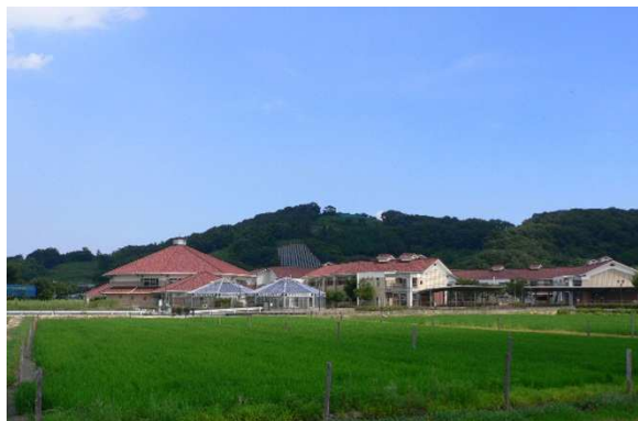
周辺景観との調和に配慮した、違和感のないまとまった形態、釣り合いの良い配置となっている
