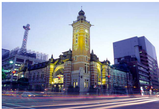
建物自体を街のシンボルとしている
