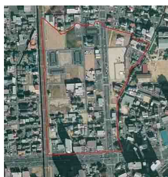
整備後 (平成24年 工事概成時)
