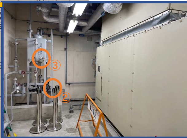
③オイルサービスタンク残量測定用バルブ
