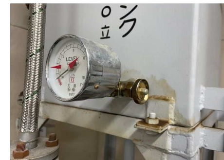
③オイルサービスタンク残量測定用バルブ
