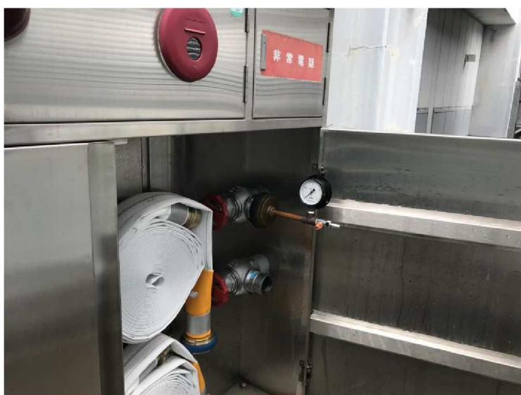
南側R F 放水口
