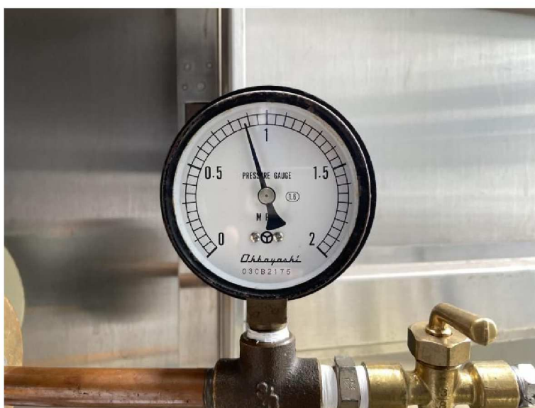
北側R F 放水口
