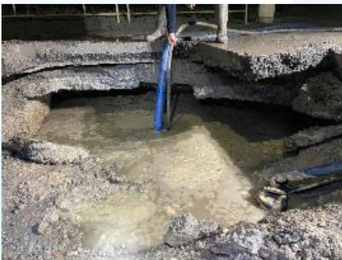
漏水状況（左）とその後の管体調査（右）
