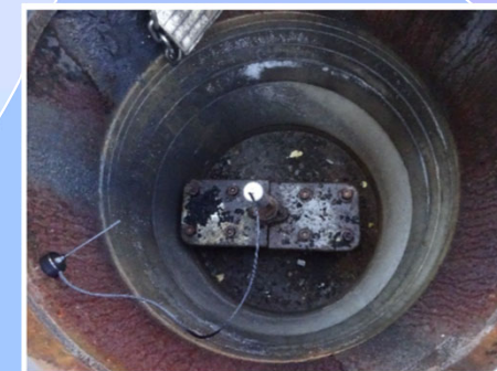
漏水音センサ設置状況
