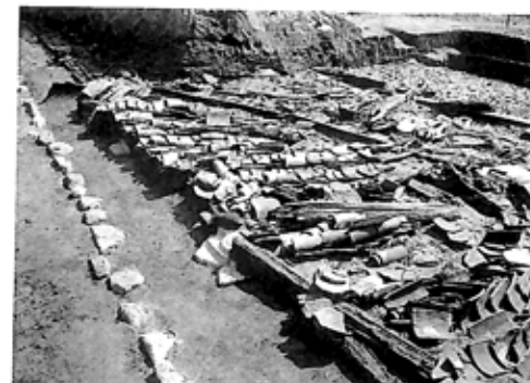
9、山田寺東回廊倒壊・瓦落下状況
