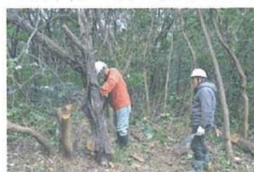
避難路路上の倒木処理
