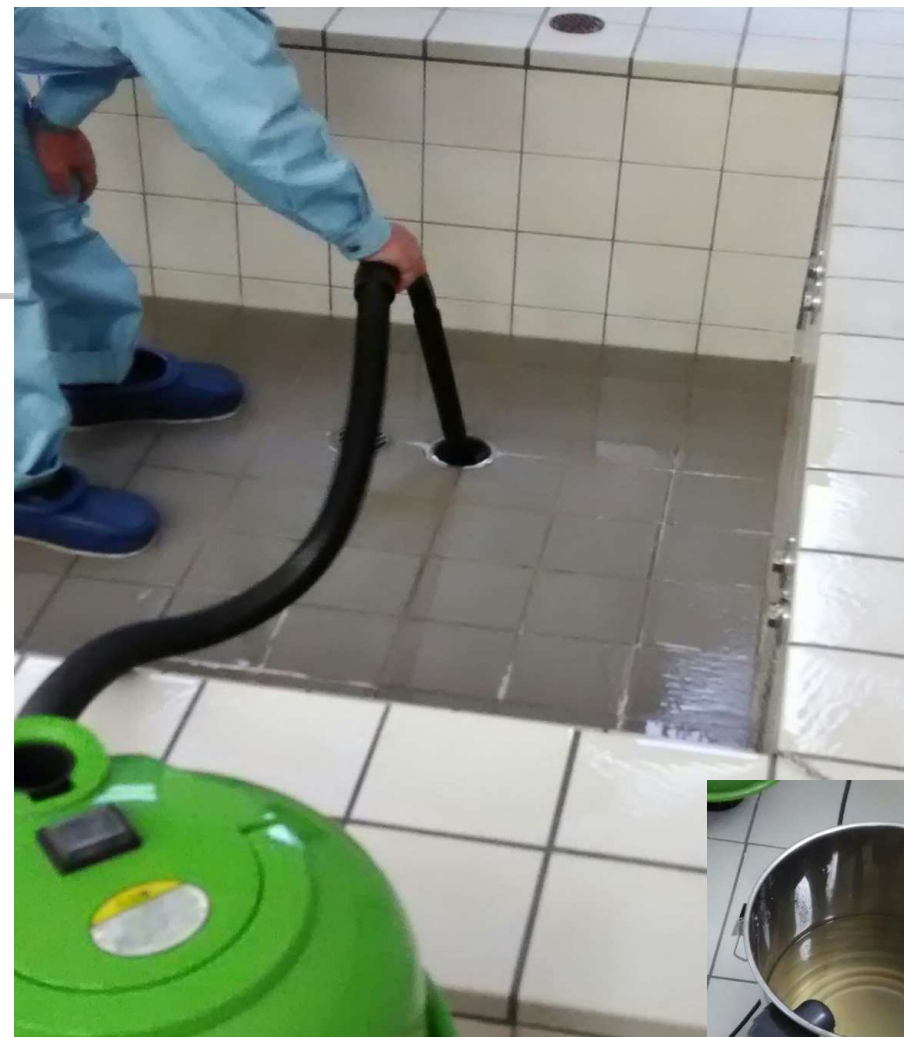
水位計配管から水を抜く作業
