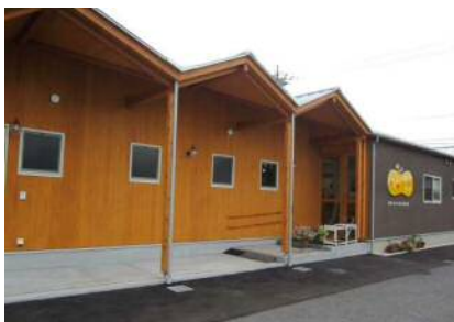
① 施設の外観。(入口付近)
