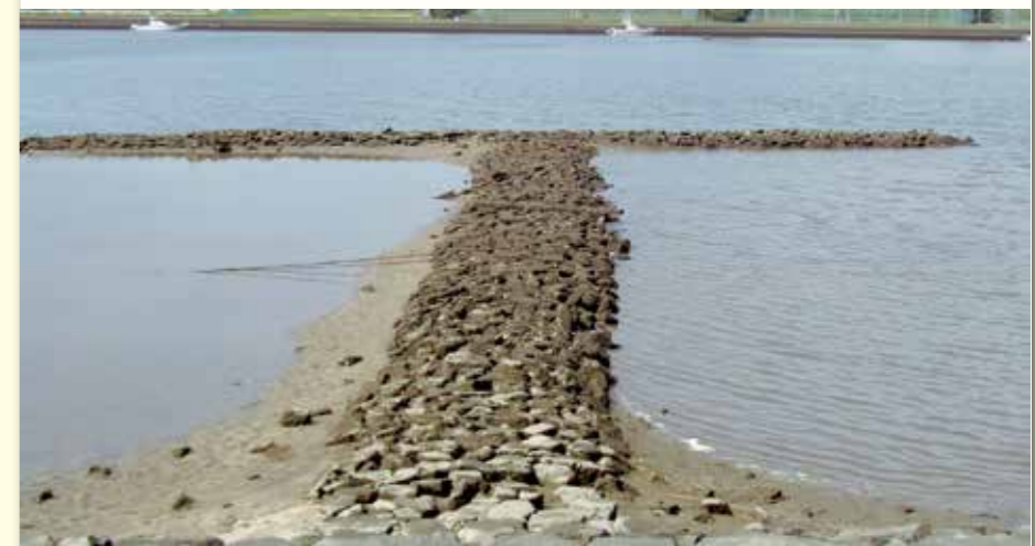
ケレップ水制 旭川河口に近い桜橋以南の左岸に、干潮時になると川の中央に向かってT字型の石積みが見えてきます。数えてみると、桜橋から旭川大橋の南まで8kmの間に計19基あります。 ケレップとはオランダ語で水制を意味します。旭川は明治時代以後、定期的に蒸気船が運航していたため川が土砂で埋まらないよう、水深を保つ役割を担っていました。旭川河口のケレップ水制のような規模のものは、全国的にも珍しく、立派なものです。
