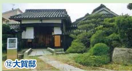
⑫大賀邸 江戸期に内陸部と瀬戸内海を繋ぐ河川交通の要衝(加子浦)として岡山藩港(今保港)が整備された。在郷商家の大賀家は、県西部の特産品であった畳表の取引を始め富商に成長した。
