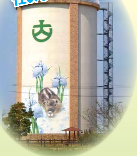
大曲用水機場 (パイプライン圧力調整タンク)
