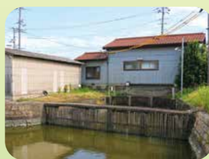
7号ポンプ場(都六区北入口)
