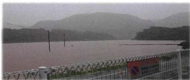
<平成 30 年 7 月豪雨による浸水の様子>
