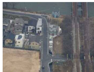
北長瀬ポンプ場 平成24年7月 稼働開始 排水能力 200m 3 /min
