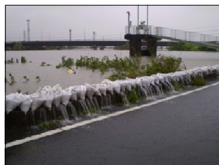
写真2-7 笹ヶ瀬川越水状況 平成23年 台風12号
