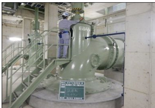
写真2-4 浦安ポンプ場ポンプ増設 436m 3 /分⇒792m 3 /分
