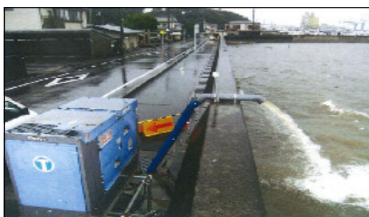
写真2-8 リースポンプによる排水状況 平成28年9月 台風16号
